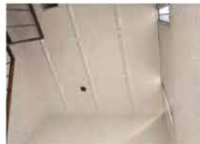
雨漏り改修工事が完了
